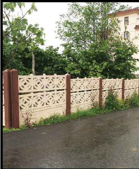
3 KATLI BAHÇE DUVARI
