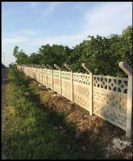
3 KATLI TELLİ DUVAR
