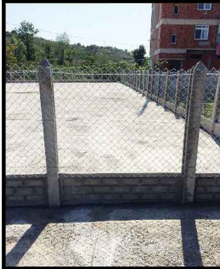
1 KATLI TEL ÖRGÜLÜ DUVAR
